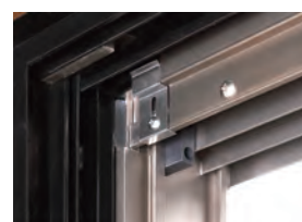
上枠アタッチの固定
