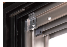
上枠アタッチの固定
