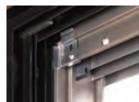
上枠アタッチの固定
