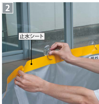
吸盤で止水シートの上部をガラスに固定し、 余ったシートをマジックテープで固定
