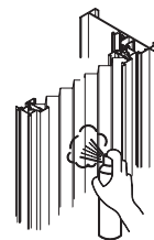
スプレー吹き付け
