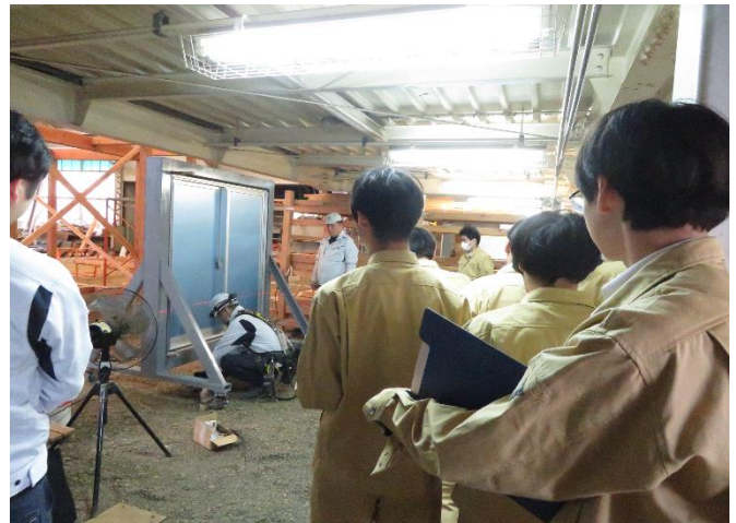
サッシの取付実習
