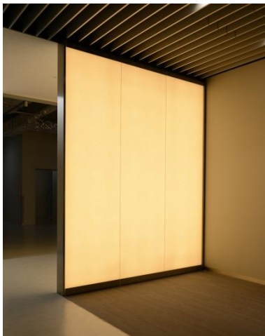
■薄さを利用し間仕切りとして施工
