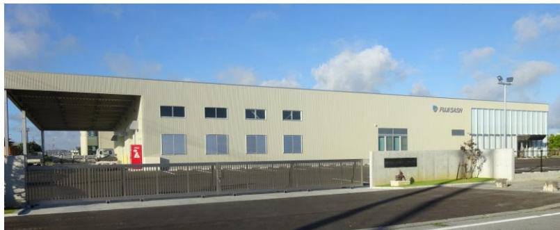
新社屋正面入り口からの全景
