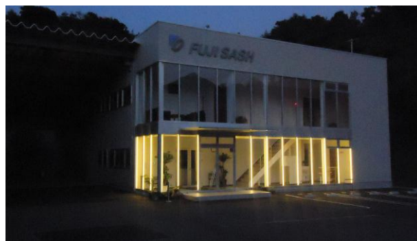
アルビームフロント点灯時の事務所正面
