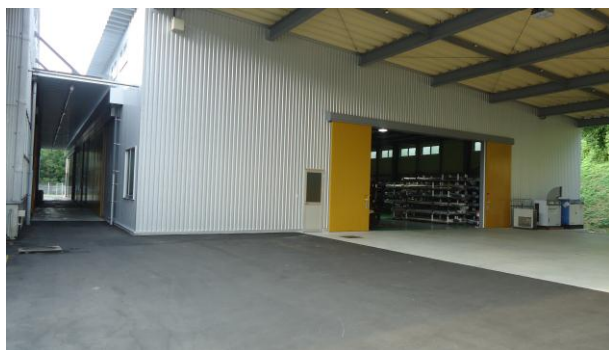
トラックヤードから見た第2工場
