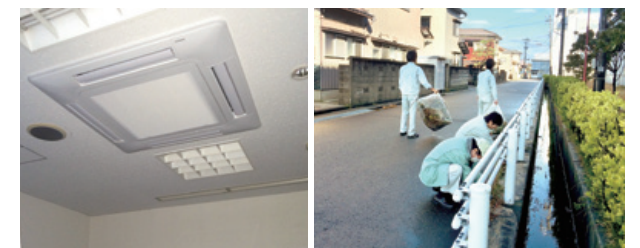
新導入したパッケージエアコン
