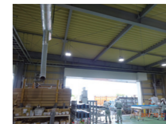
工場にLED照明、スポットクーラーを設置
