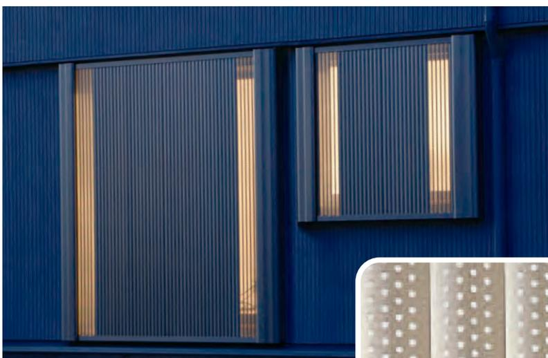
両端5枚にφ3mmのパンチング孔を空けた両袖パンチングタイプは、昼間は木漏れ日が差し込む室内空間を、夜間は室内に灯った灯りで幻想的なイメージを演出します。
