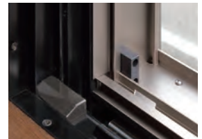
下枠は網戸レールに引っ掛けるだけ
