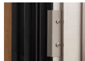
たて枠アタッチの固定
