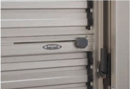
クレセント／ルーバー開閉レバー
