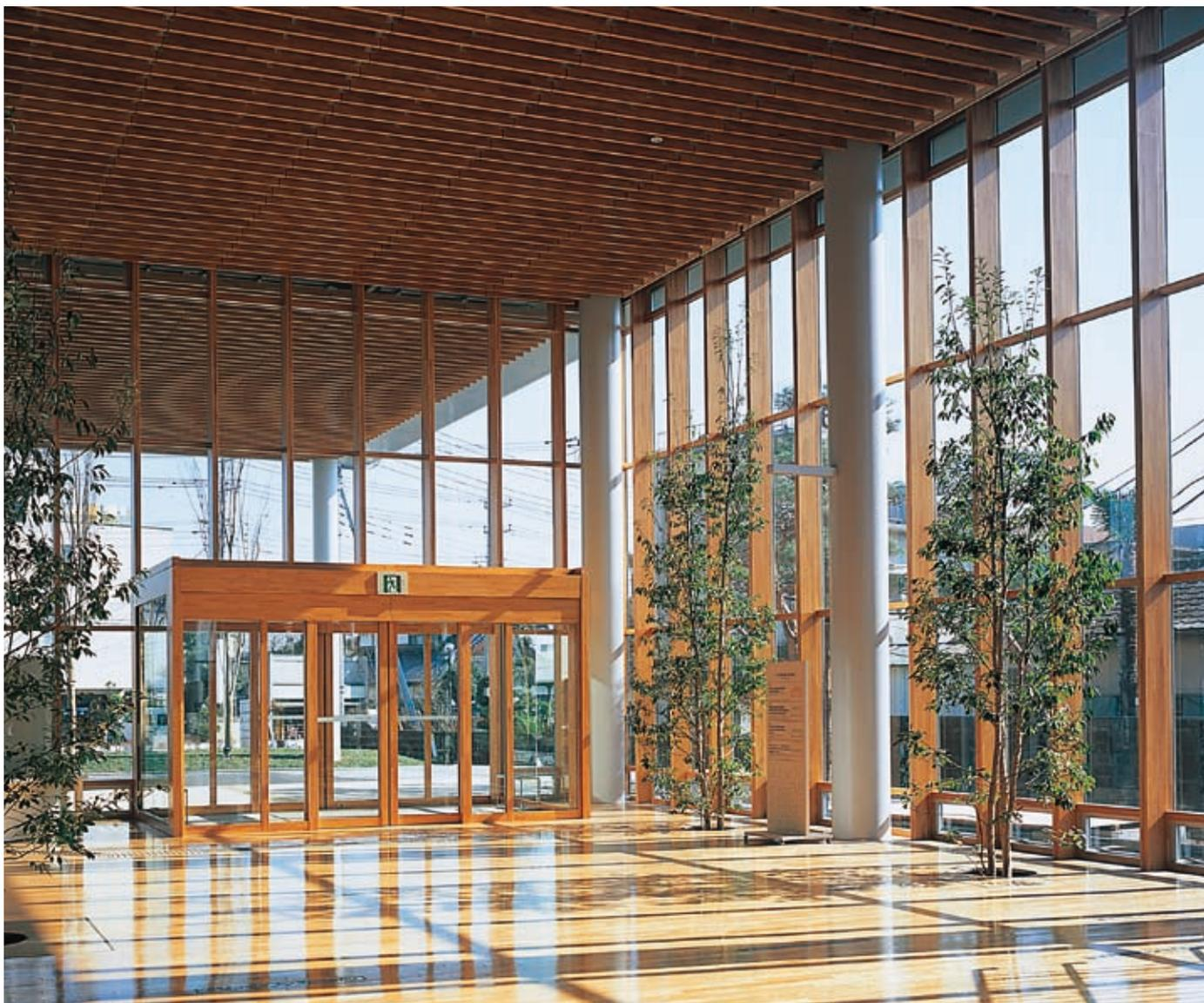
スチールとアルミを構造体とし、木部分を装飾材としたカーテンウォール。外観はアルミのシャープなイメージ、内観は天然木集成材の美しい木目による暖かい質感が表現されています。アルミ材には熱伝導率の低い特殊ポリウレタン樹脂を注入することで高い断熱性を実現し、結露の発生を抑えます。木部には、有害物質を含む接着剤は一切使用しておらず、キズ防止の養生を最小限にとどめることができるよう、環境にも配慮しています。
