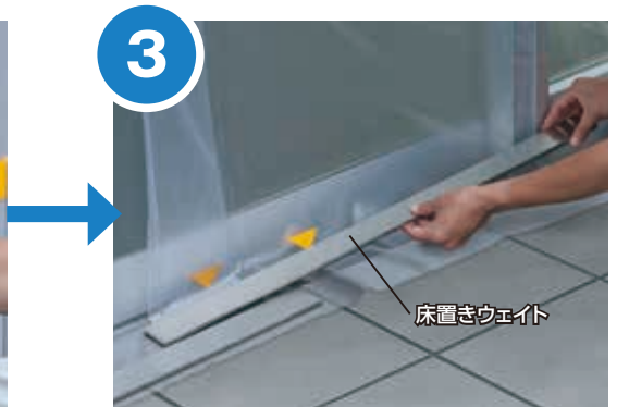
止水シートの下部を床置きウエイトで押さえる
