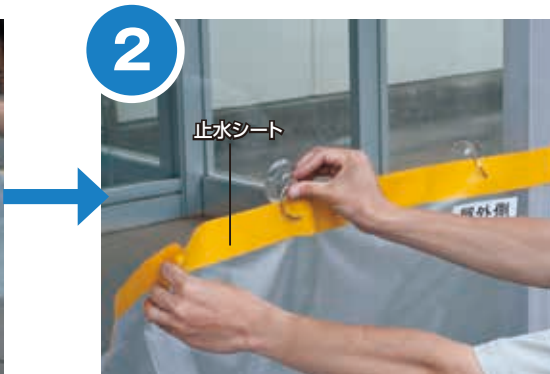
吸盤で止水シートの上部をガラスに固定し、余ったシートをマジックテープで固定
