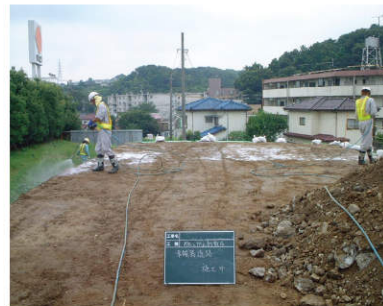
工事用道路(非通行部)
