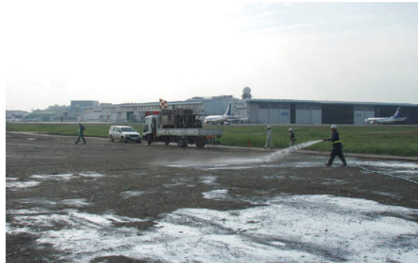
ハイドロシーダーによる施工状況
