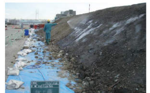
散布の様子 (法面)
