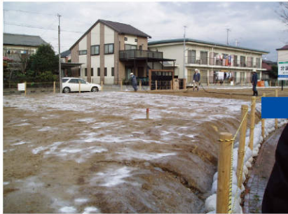
施工直後の状態
