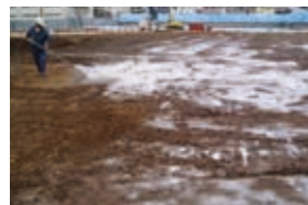
散布の様子 (平地)
