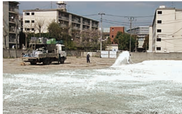
ハイドロシーダーによる施工状況
