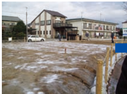
施工直後の状態
