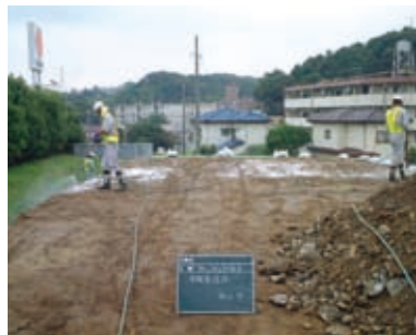
工事用道路(非通行部)
