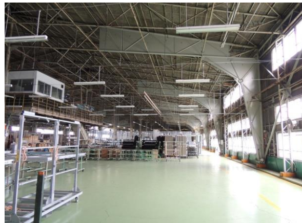
スチールプレート式 耐震補強
