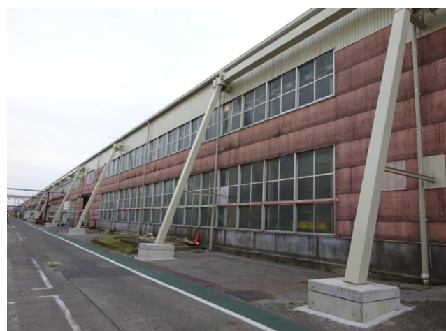
アウトフレーム式 耐震補強
