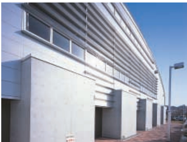
岐阜県関市 岐阜県立関養護学校 屋体・プール
