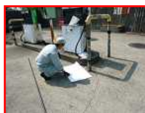
(写真2) 配管に吸着剤と流れ止めを施す。
