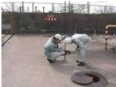
<写真1> 検査穴に検尺棒を入れて漏れの確認。
