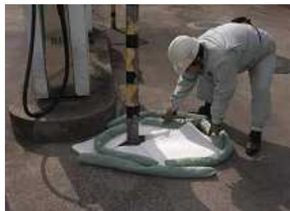
<写真2> 配管に吸着剤と流れ止めを施す。
